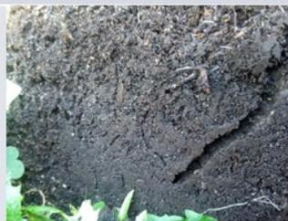
Er ist die Grundlage für die Vegetation auf der Erdoberfläche. Daher ist er vor der Baumaßnahme abzutragen und getrennt von den anderen Aushubmassen (rechts im Bild zu sehen) zu lagern.
