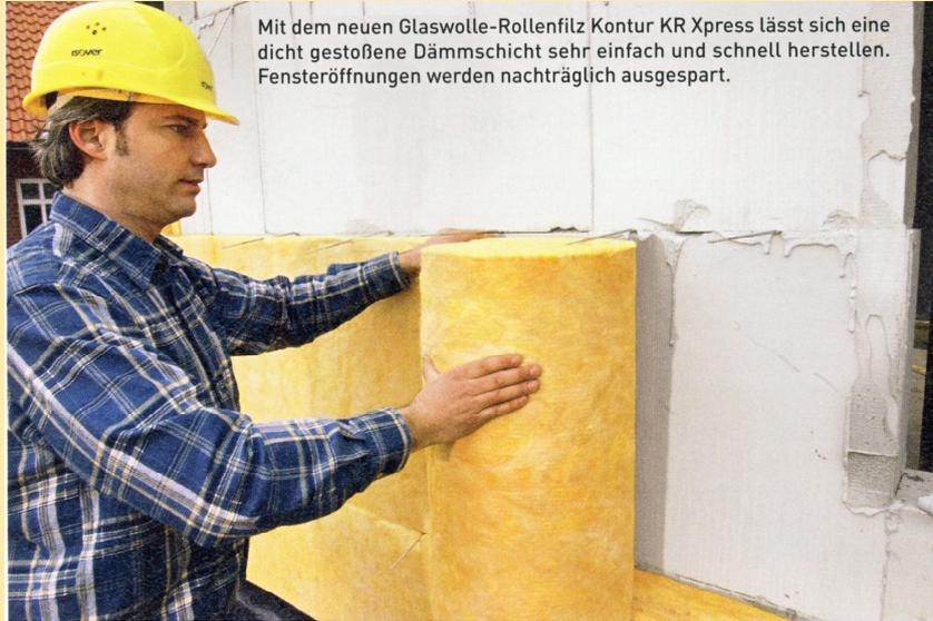
Mit dem neuen Glaswolle-Rollenfilz Kontur KR Xpress lässt sich eine dicht gestoßene Dämmschicht sehr einfach und schnell herstellen. Fensteröffnungen werden nachträglich ausgespart.
