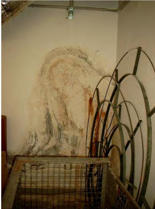
Links typisches Bild aufsteigender Feuchte, rechts Messgerät
