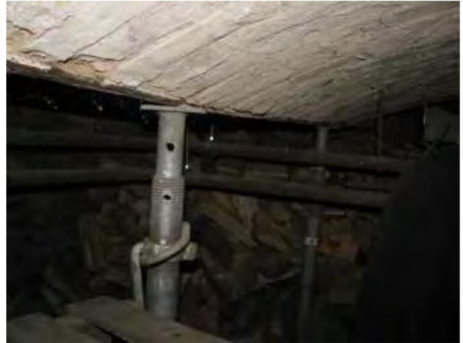
Preußische Kappen auf stark korrodierten Trägern mit verschiedenen Abstützungen (Spindelspreize und Mauersockel)
